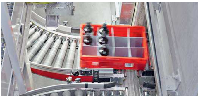
⑥ Die roten, befüllten Behälter werden per Fördertechnik ins AKL eingelagert
